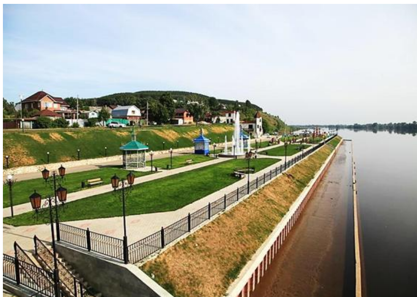
Рис. 1. Первая очередь берегоукрепительных сооружений в г. Мамадыш
