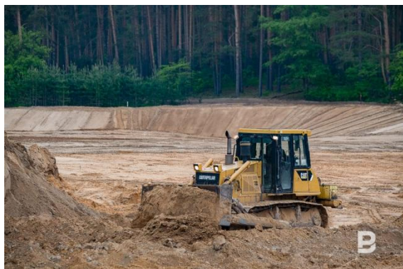
Рис. 1. Создание котловины пруда.
